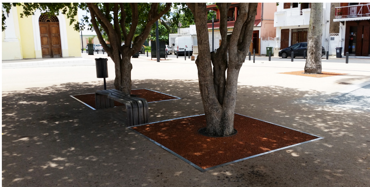
fosses de plantations recouvertes de résine perméable pour préserver la qualité du sol et sa ressource en eau (Port-Louis)
